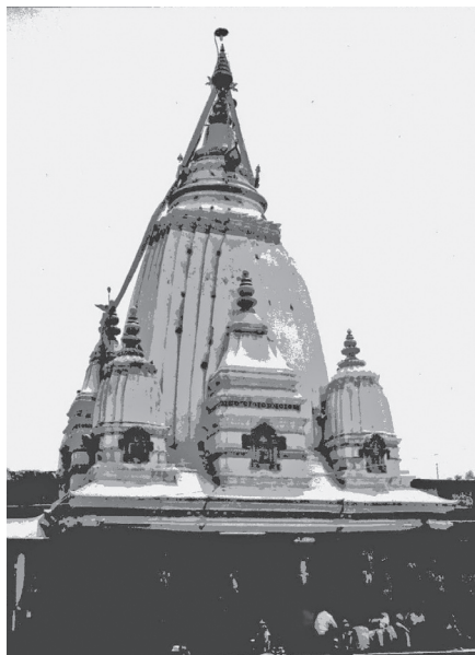
Рис. 4. Храм Красного Мачхендранатха. Бунгамати. Разрушен во время землетрясения в апреле 2015 г.
